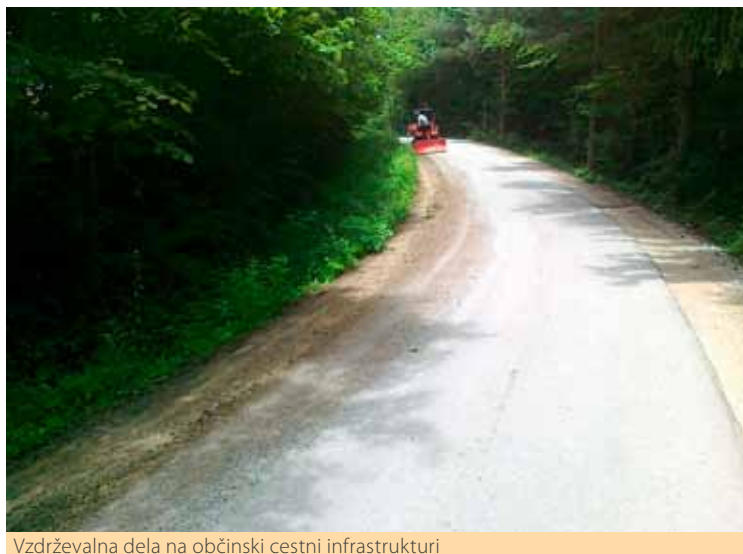
Vzdrževalna dela na občinski cestni infrastrukturi
