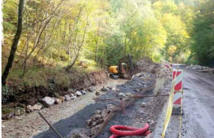
Sanacija brežine potoka Dobrnice v Hudičevem grabnu
