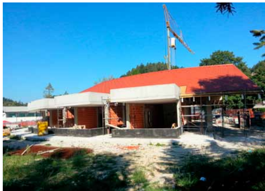
Gradbišče Vrtec Dobrna
