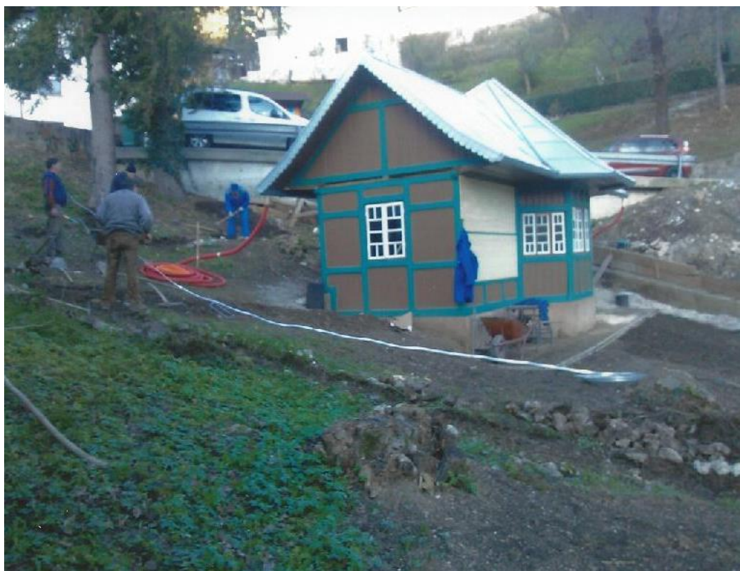
Slika 19: Vkop električne napeljave in urejanje okolice. Idrija, 29. 11. 2013 (foto: Martin Kolenc)
