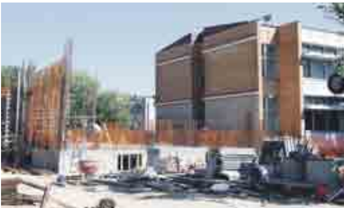
Izgradnja prizidka k OŠ Rodica
