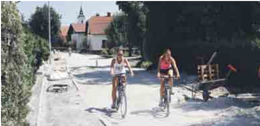
Rekonstrukcija ceste Radomeljske čete v Radomljah
