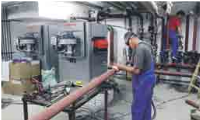
Rekonstrukcija kotlovnice na OŠ Venclja Perka
